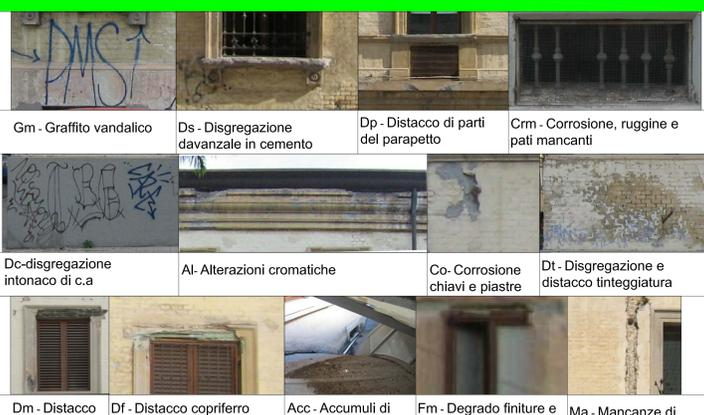
Gm - Graffito vandalico Ds - Disgregazione avanzata in cemento Dp - Distacco di parti del parapetto Crm - Corrosione, ruggine e parti mancanti
